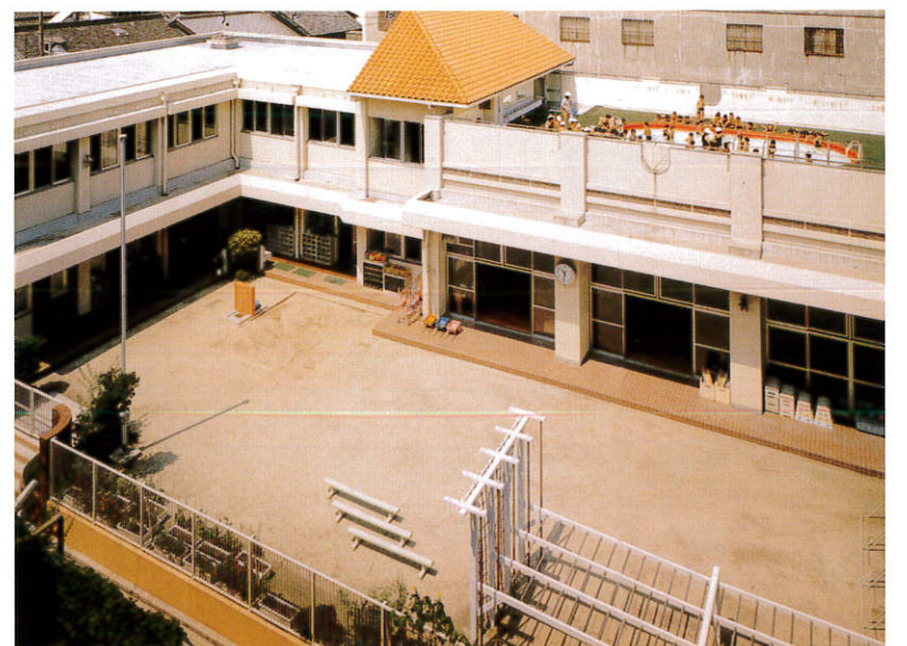
菅南幼稚園新園舎
