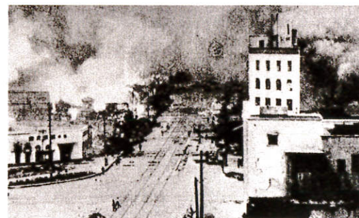
火災を起す桜橋交差点付近
