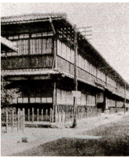
菅南尋常小学校旧校舎南西隅
