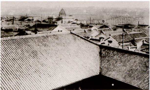
校舎屋上より南東を望む(大正12年)
