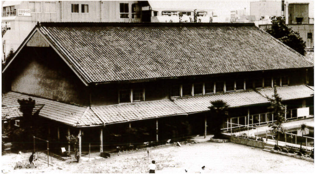
西天満小学校講堂 大正11年5月竣工・昭和30年9月移転・昭和50年3月解体
