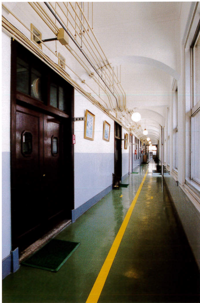
廊下の天井アーチ
