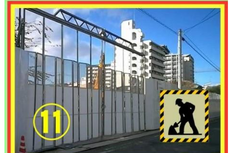
⑪ 工事中で夜が暗い
