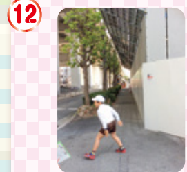
マンションの建設現場で歩 道がせまい。あぶないので 慎重に通る。
