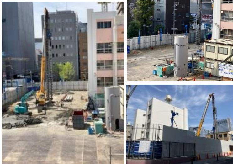
クラブハウスや体育倉庫などがあったエリアが更地に整地され、新校舎増築の基礎工事が始まりました。杭打ちの重機やコンクリートを流し込む設備がセッティングされています。教育活動を妨げないように急ピッチで工事が進められています。
