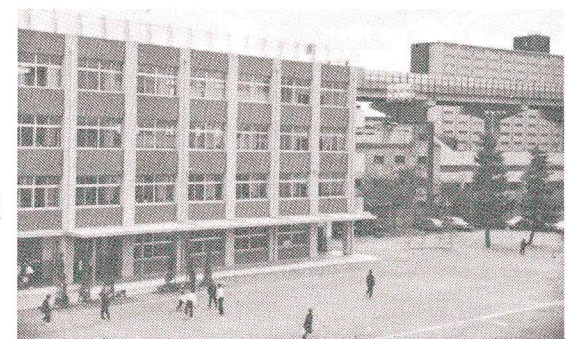
南館校舎鉄筋4階建第2期工事
