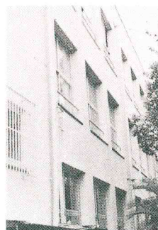
北館校舎外壁改装
